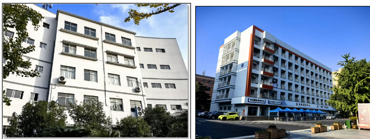
图 6-3 外立面改造后的第一实训楼和学生公寓
