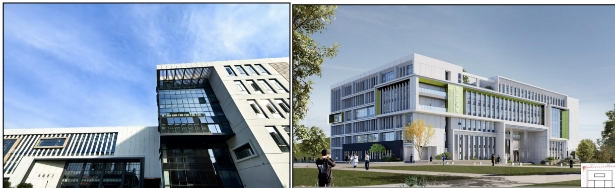
图 6-2 实训教学用房及新食堂、第二实训楼
